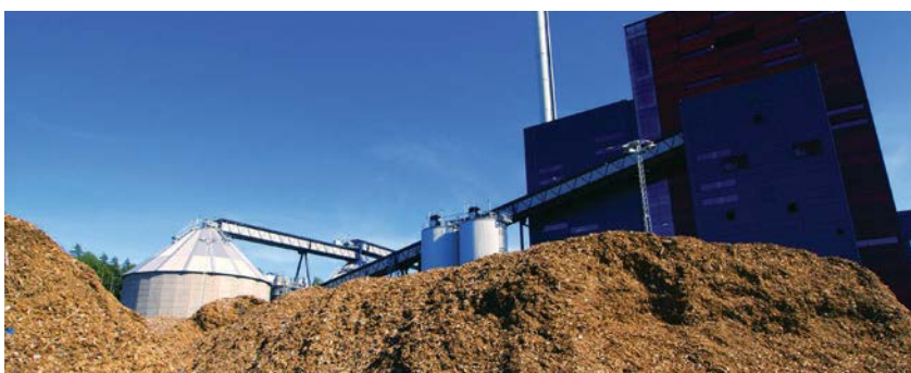
ENERGÍA DE BIOMASA
